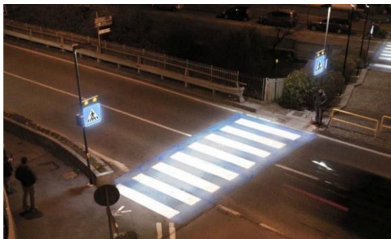
Рисунок 3.14 – Пример дополнительного освещения на пешеходном переходе
